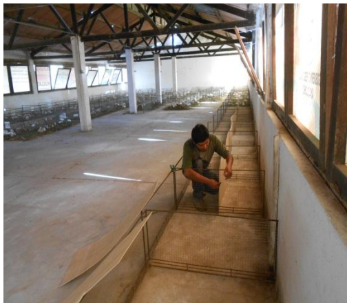
Foto 03: Instalación y habilitación de pozas
