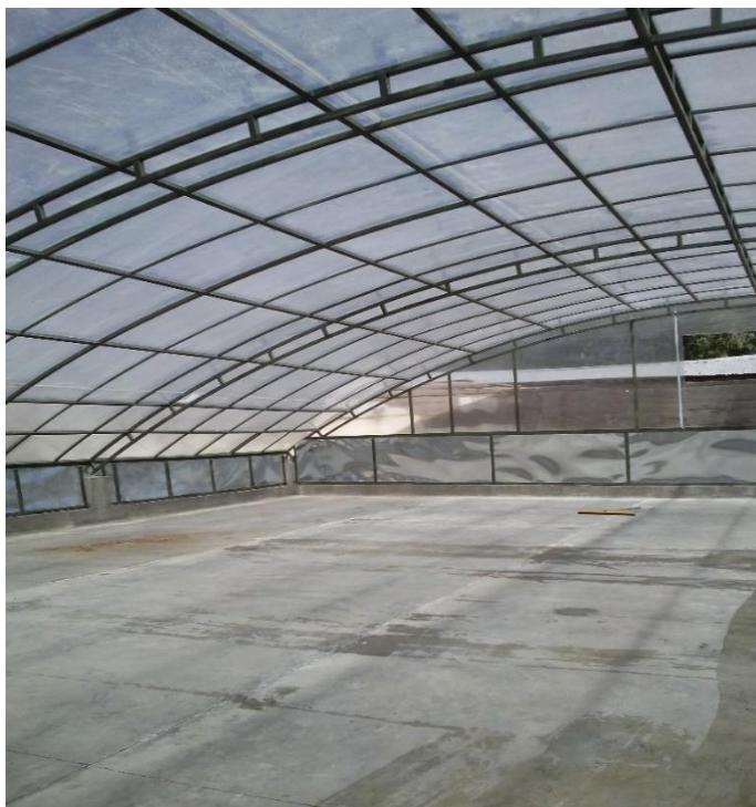
Figura n° 4.26: Vista de la construcción concluida
