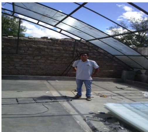
Figura n° 4.21: Vista de un avance del techado
