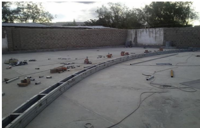
Figura n° 4.16: Armazón de vigas de metal en forma de U.
