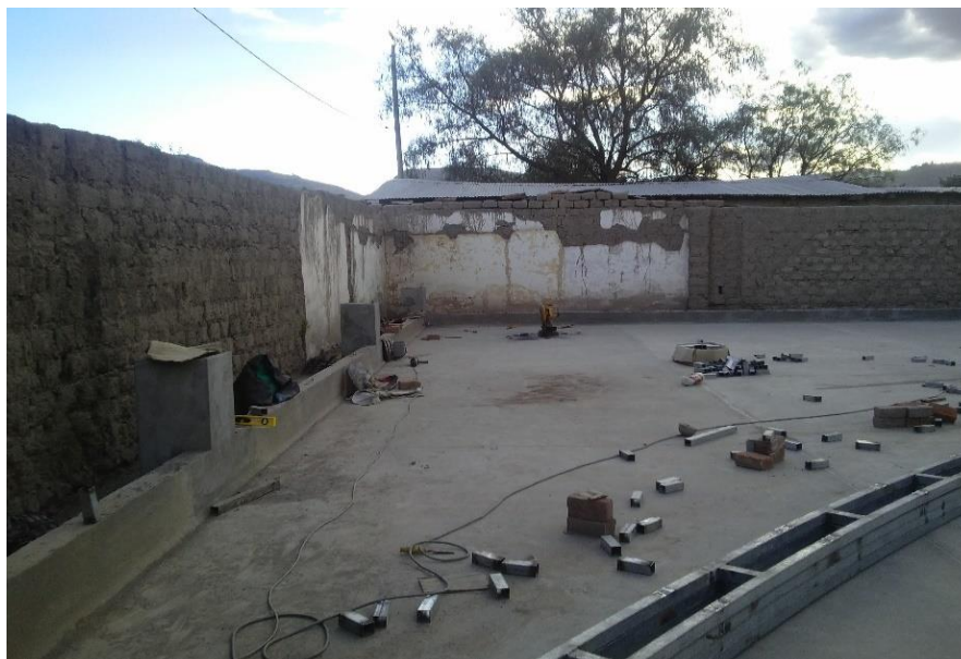
Figura n° 4.15: Columnas de soporte
