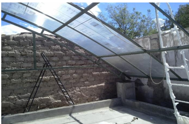
Figura n° 4.20: Inicio del techado con policarbonato
