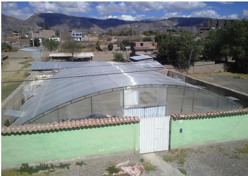
Figura n° 4.22: Secador solar concluido con el techado.
