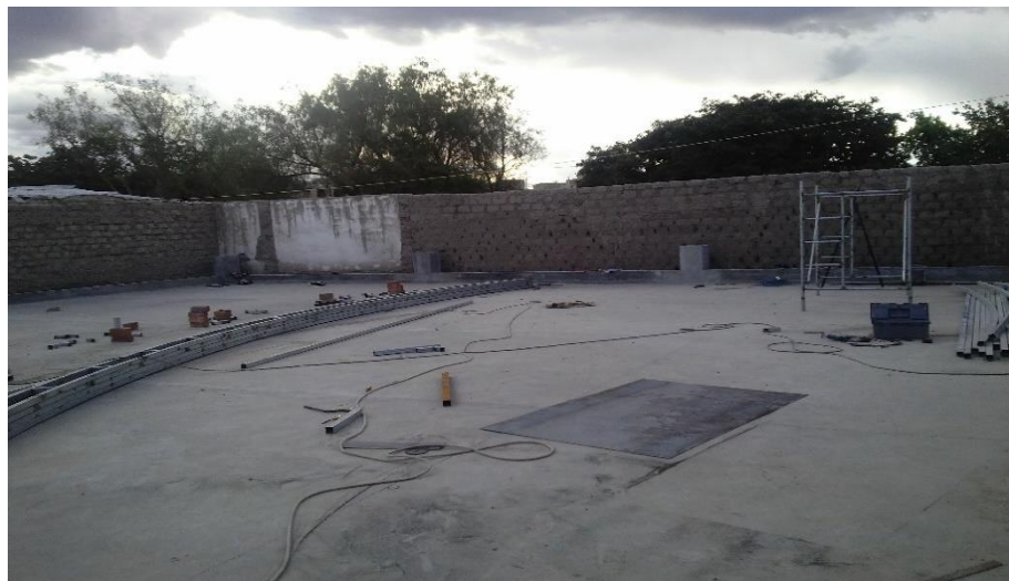
Figura n° 4.14: Espacio para la construcción
