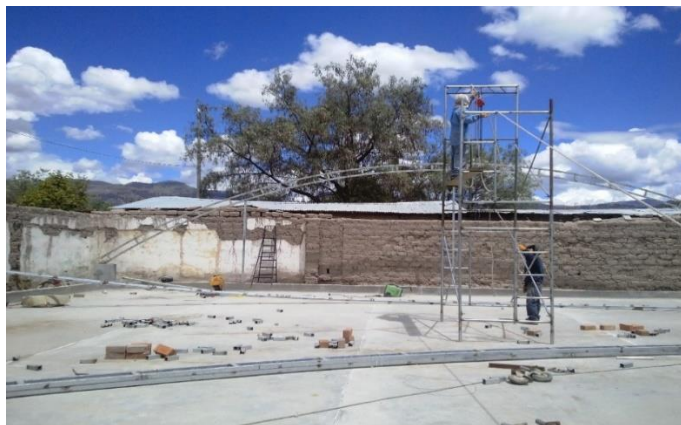
Figura n° 4.17: Colocación de las vigas de metal.
