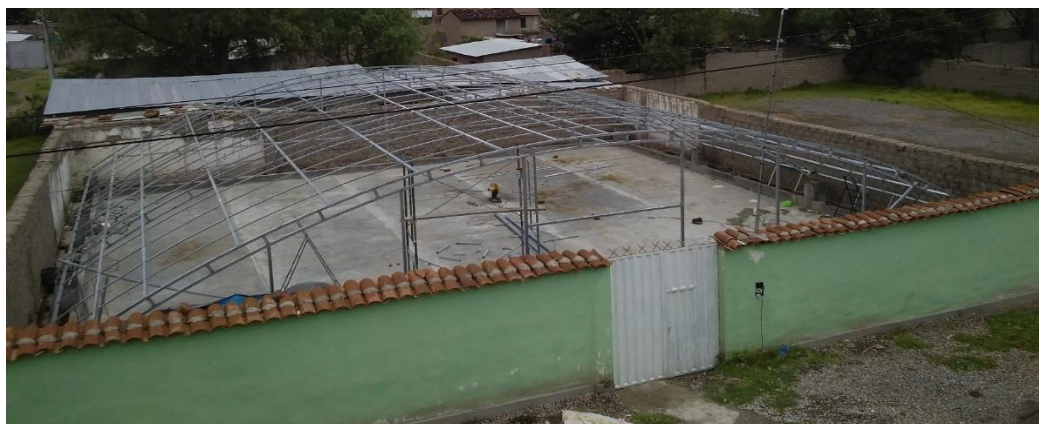
Figura n° 4.18: Armazón del secador solar.
