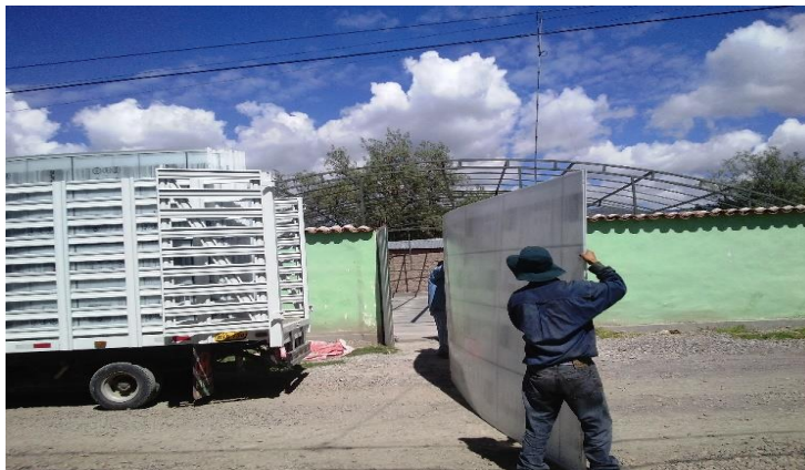
Figura n° 4.19: Recepción del policarbonato.
