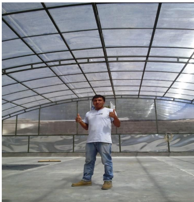
Figura n° 4.27: Vista del interior del secador solar.
