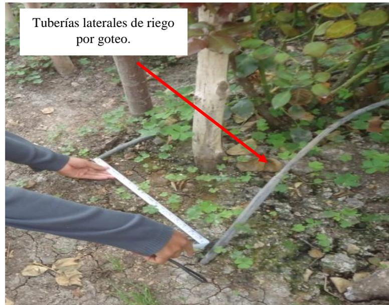
Figura 3.36. Instalación de tuberías laterales de riego por goteo
