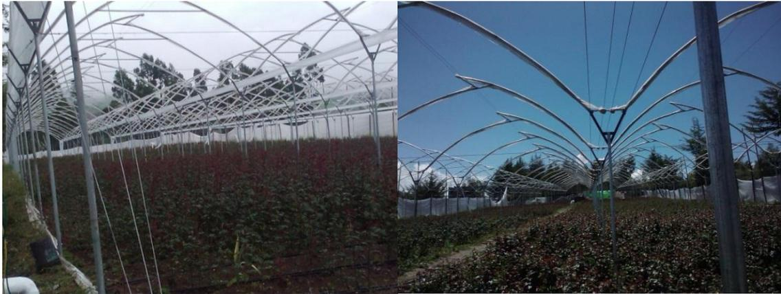
Figura 3.8. Alineamiento y tensión de cables      Figura 3.9. Colocación de cerchas y tensionad
