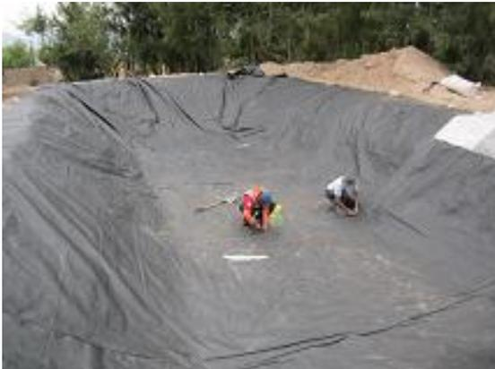
Figura 3.15. Colocado y estirado de la malla
