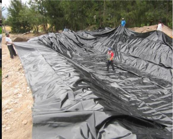
Figura 3.22. Pozo con capacidad de almacenamiento Figura 3. 23. Recubrimiento con geo-membrana
