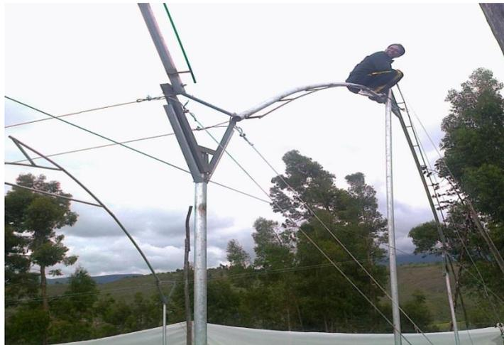
Figura 3.10. Tensión de cables y colocación de P8
