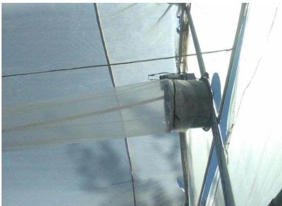
Figura 3.11. Ventiladores con tubo plástico
