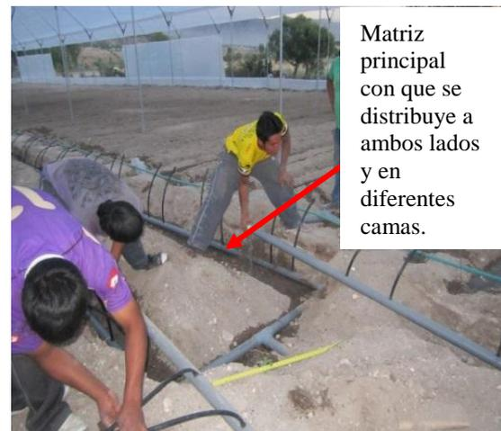
Figura 3.31. Instalación de tuberías principales y secundarias para cada válvula.
