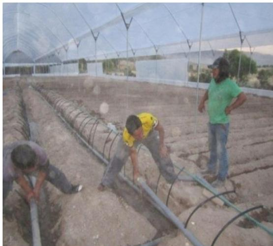
Figura 3.20. Instalación de las tuberías y los goteros
