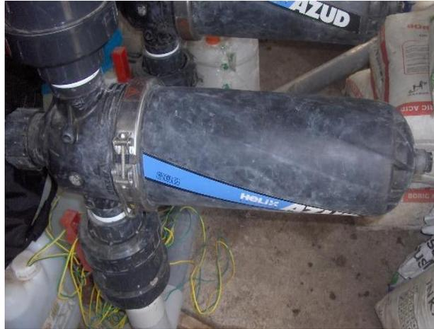
Figura 3.27. Sistema de azud hélix instalado y funcionando en la empresa
