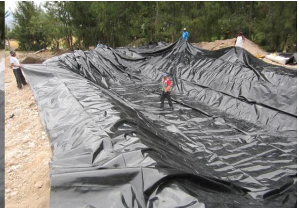
Figura 3.16. Colocado y estirado de la Geomembrana
