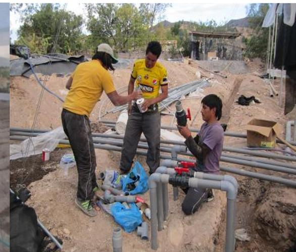
Figura 3.21. Instalación de válvulas y Sist. Venturi.
