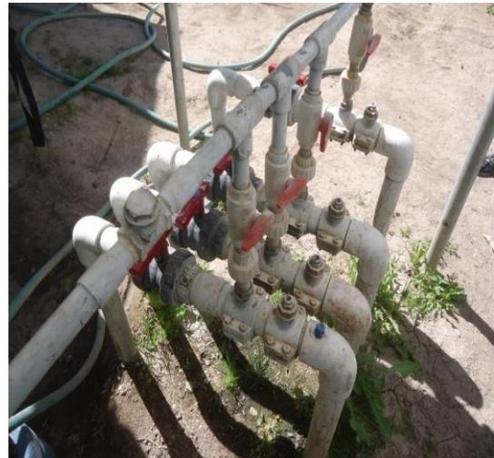
Figura 3.34. Sistemas de válvulas que cada una abarca una área determinada y se monitorea el área que se irriga.
