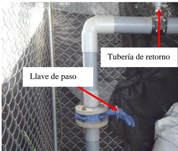
Figura 3.30. Tubería principal que conecta la bomba centrífuga (que succiona el agua del reservorio) y conduce al filtro
