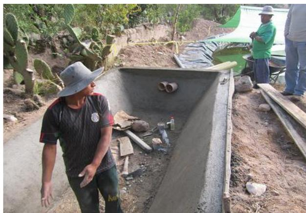
Figura 3.17. Construcción del desarenador
