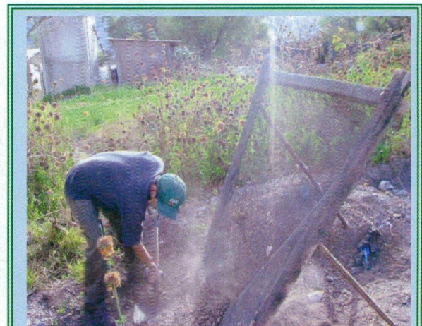
Foto 10: Limpieza y tamizado del suelo.
