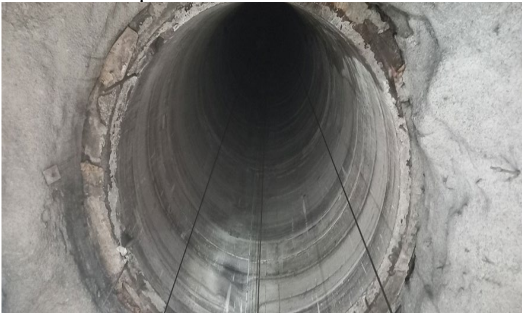
Figura 64. Pique Circular Carlos después de haber desencofrado el último anillo Nv 14
