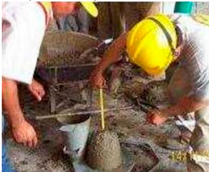
Figura 79. Prueba por asentamiento (Concreto normal)
