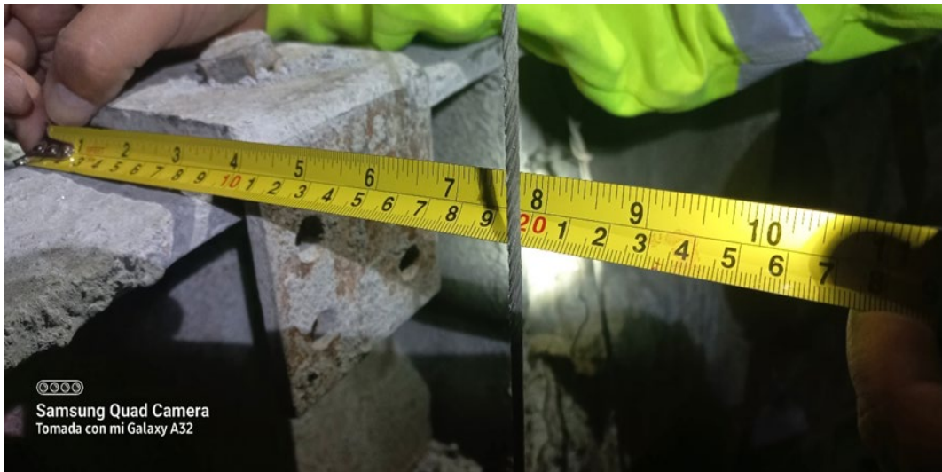
Figura 61. Centrado y alineado de la forma F de 5m de diámetro para el encofrado y revestimiento de pique Carlos
