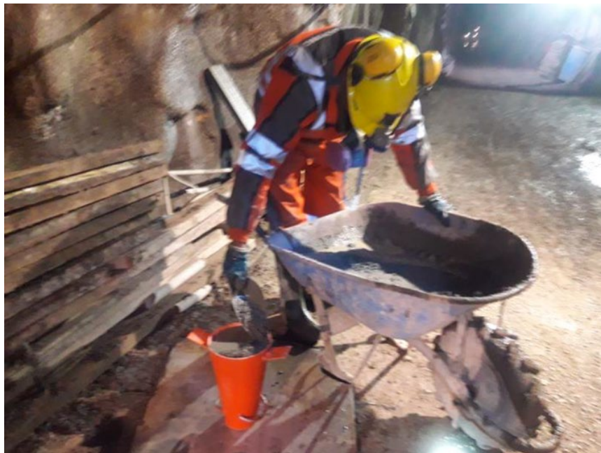
Figura 81. Colocación de concreto en el cono de Abrams
