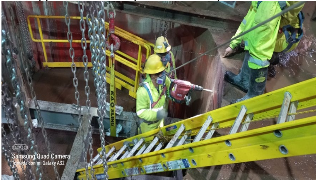
Figura 66. Alineamiento y perforación de taladros para los insertos en Pique Carlos en el Nv 4500
