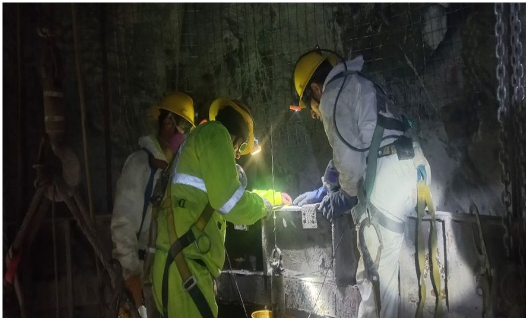
Figura 62. Protocolo de cumplimiento de alineado de la forma F a 20cm a las 4 plomadas en Pique Carlos
