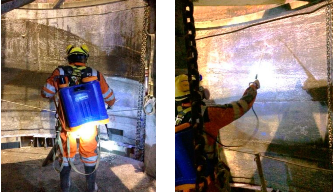
Figura 91. Curado de concreto
