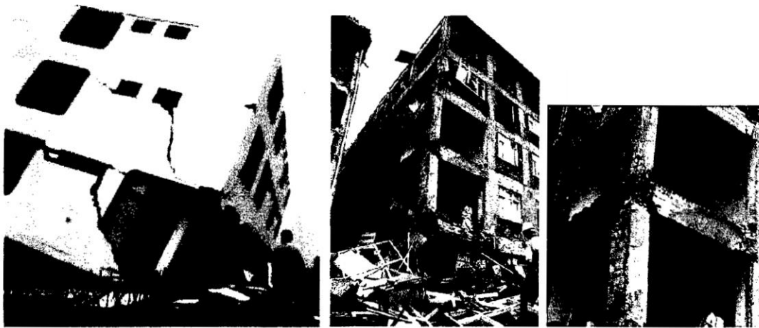
Figura 1.4: Falla por comportamiento no dúctil de las vigas de concreto armado (Piso Débil)
