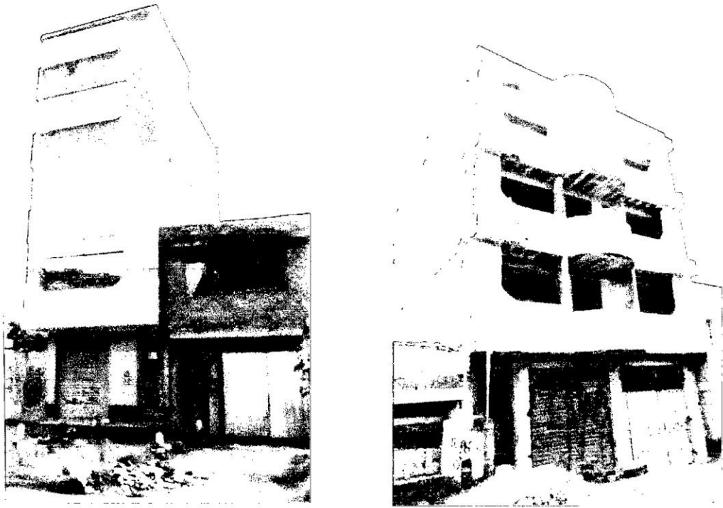
Figura1.1: Edificio de 5 pisos Sec. Maravillas, Edificio de 4 pisos Sector público
