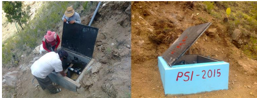
Figura 7: Cámara rompepresión tipo 7 con control de nivel
