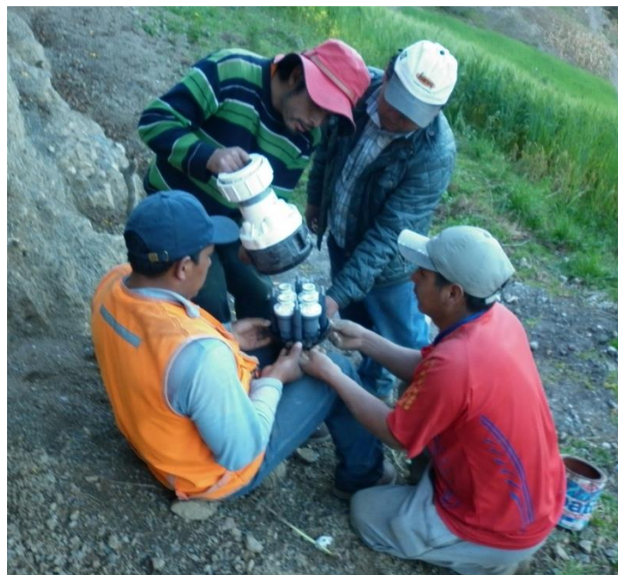
Figura 12: Ensamblado final de reguladora de presión
