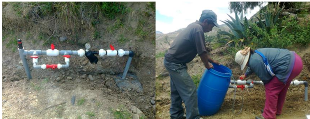
Figura 20: Arco riego de 1 1/2'' en imagen izquierda y imagen derecha prueba de fertilización con inyector Venturi de 3/4''
