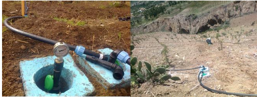
Figura 17: Lateral de riego para el traslado al siguiente turno de riego
