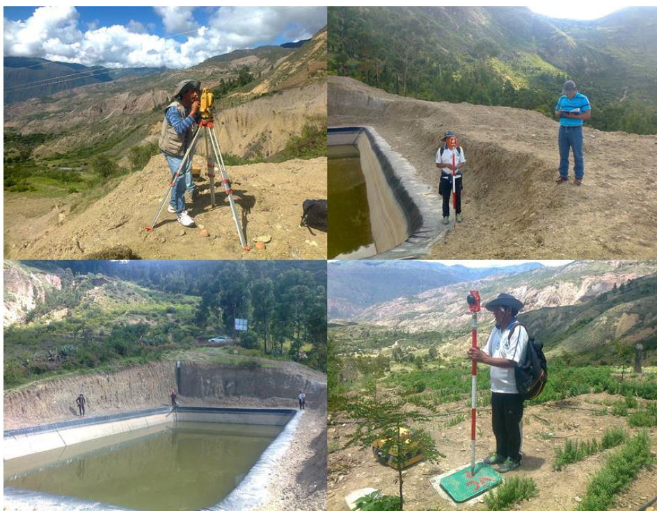
Foto 1. Realizando nuevo trabajo topográfico desde toma de captación con estación total.
