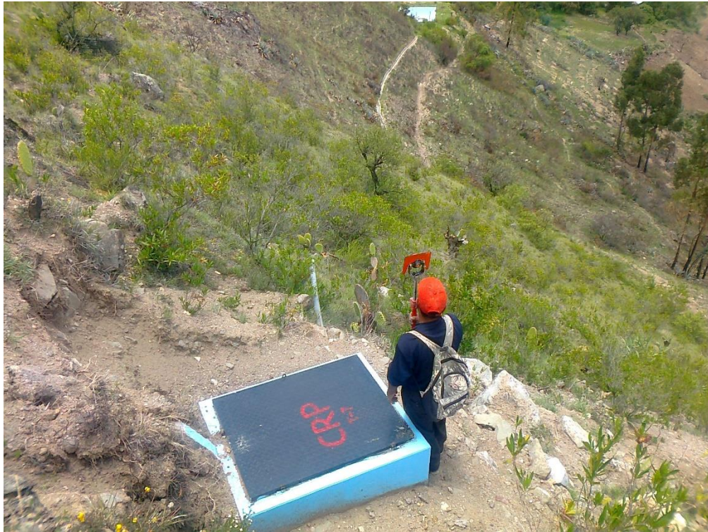
Foto 3. Ubicación de Cámara rompe presión con estación total, se observa el prisma tomando lectura.
