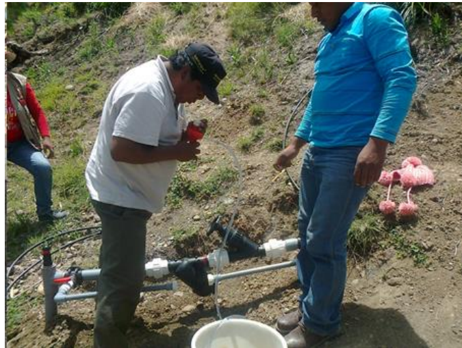
Figura 19: Limpieza de filtro de anillo 120 mesh en arco riego de 2''
