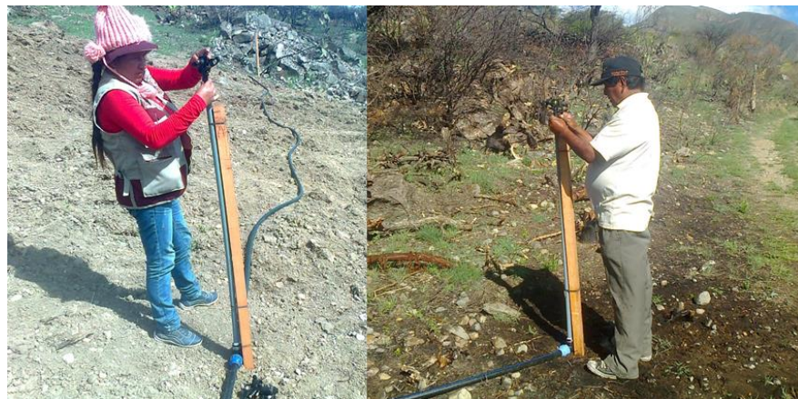
Figura 18: Instalación de apersores en lateral de riego en el siguiente turno
