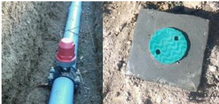
Figura 13: Válvula de aire de 1" de doble cámara
