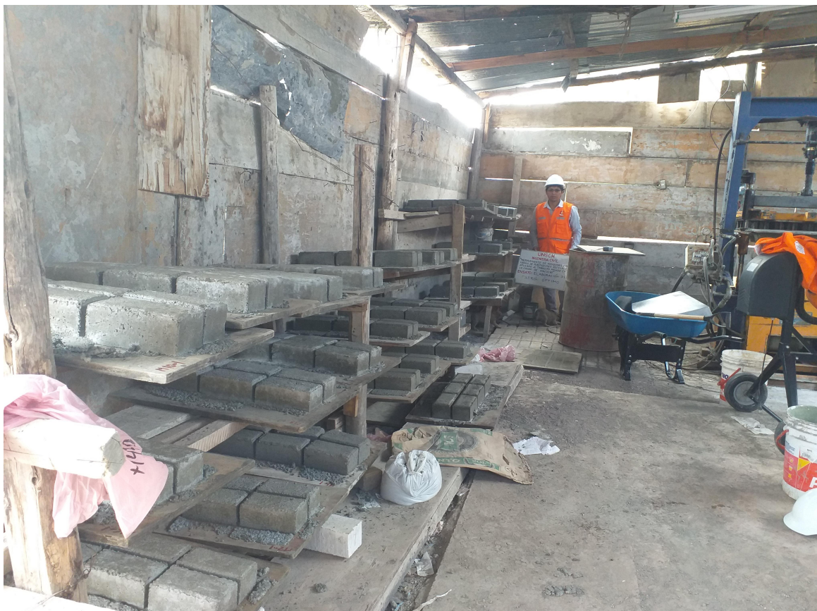
Figura 23 Adoquines de concreto en fase de endurecimiento
