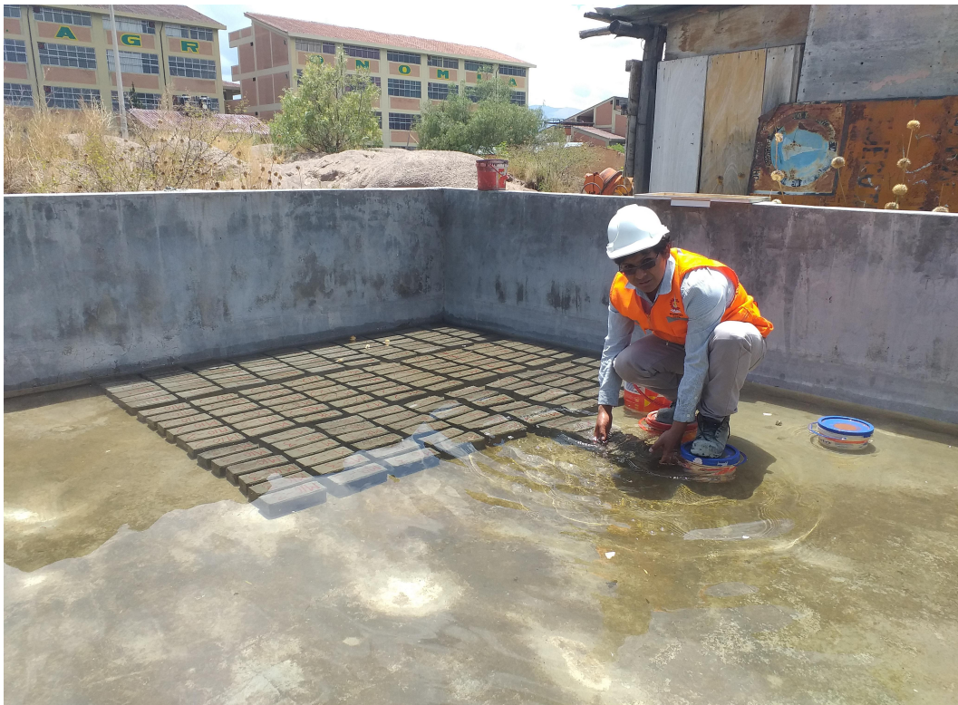
Figura 25 Curado del adoquín con sumergimiento total
