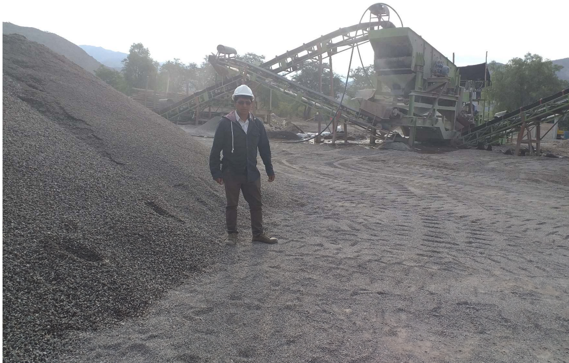
Figura 8 Visita a cantera para extracción de Material
