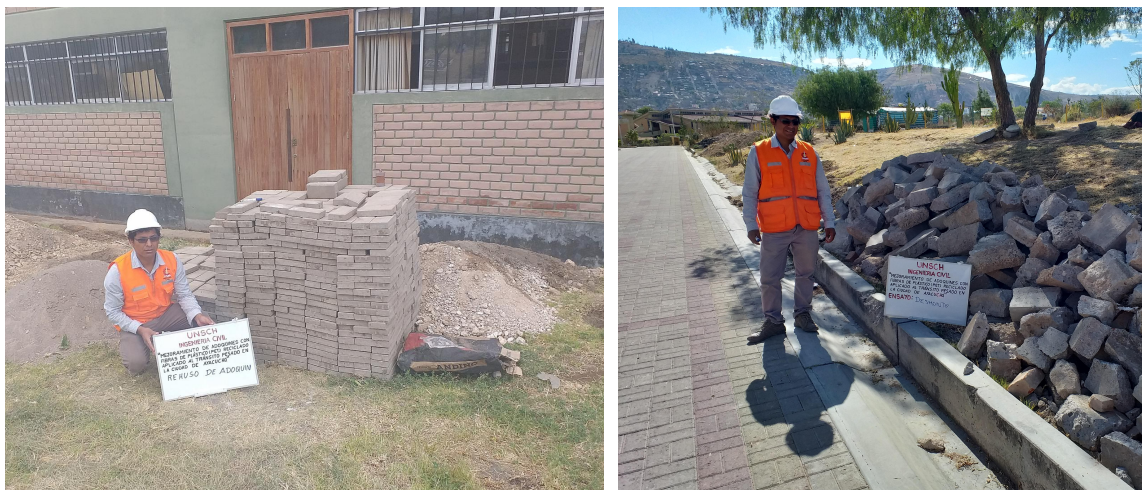
Figura 4 Reutilización de adoquines en la Ciudad Universitaria Módulos UNSCH. En un mismo proyecto se observa en la primera imagen que se está reutilizando el adoquín para su posterior rehúso, mientras que en la segunda imagen se muestra el pavimento rígido. Fuente: Elaboración propia
